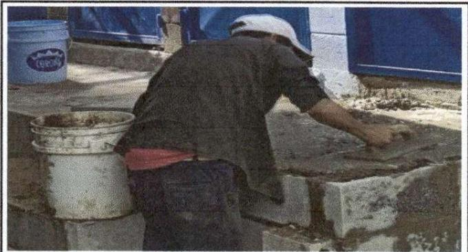
Foto 4: Reparación de piso de torta de concreto.
