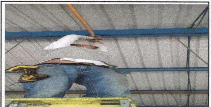
Foto 12: Sustitución de lamparas tipo LED.
